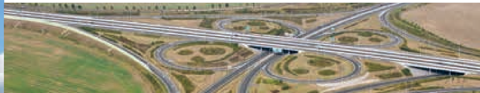
Rychlostní silnice R35, stavba 3509 Slavonín – Přešovice
