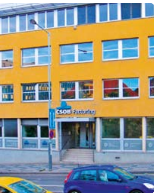
Sídlo společnosti ČSOB Factoring v Benešovské ulici v Praze 10
